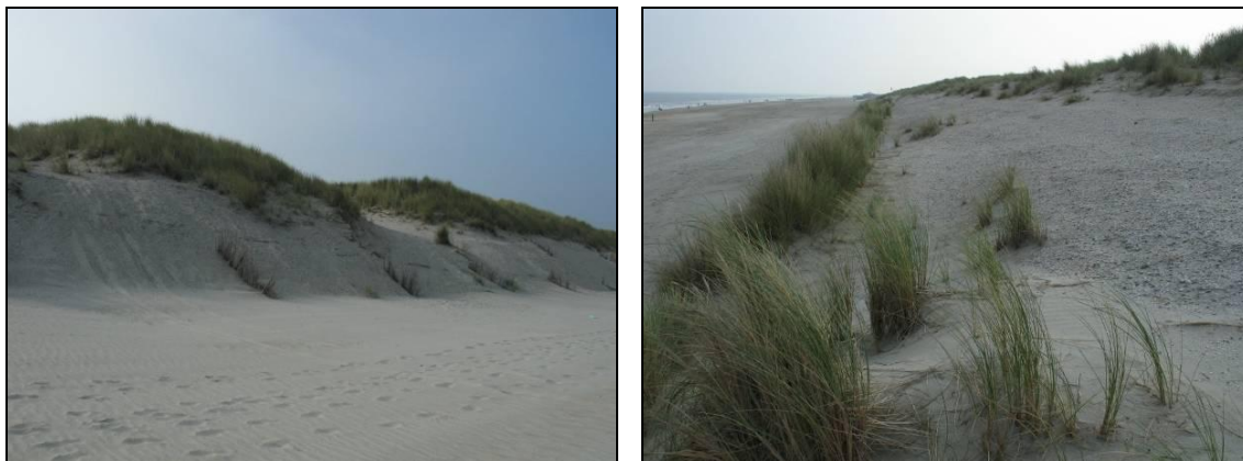
Figuur 6.5. Duinverzwaring met schelprijk zand tussen paal 12 en 15.
