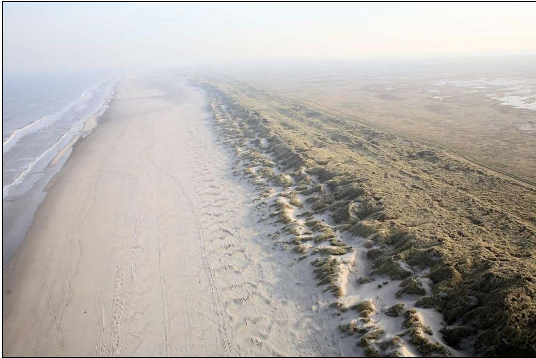
Foto: RWS, J. van Hout Luchtfotografie. Fotonummer 36. De stuifdijk ter hoogte van km 22. Geen schade door de storm. Dynamiek beperkt zich tot de voorzijde. De achterkant is geheel verward.
