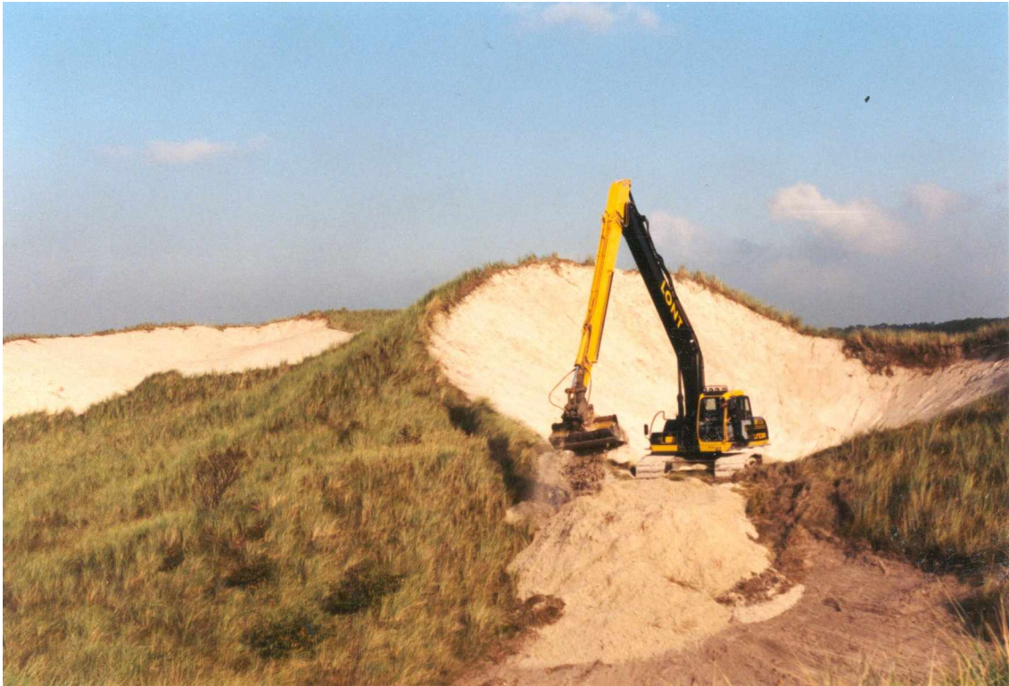
Figuur 1.1. Werk in uitvoering bij kuil 1.
