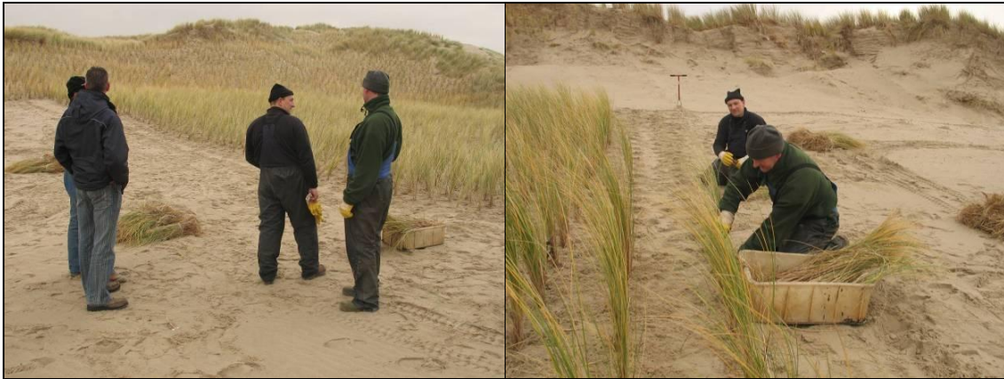
Figuur 3.2. Inplanten van de dichtgeschoven kerf met Helm.
